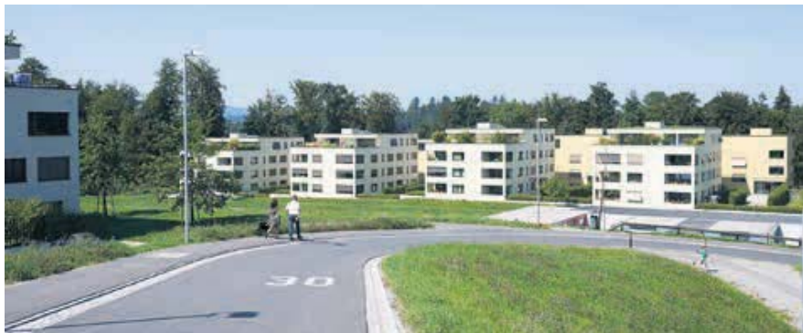
Statt architektonischer Schnörkel zahlbare Mieten und hohe Lebensqualität: die Überbauung Unterlöchli.
